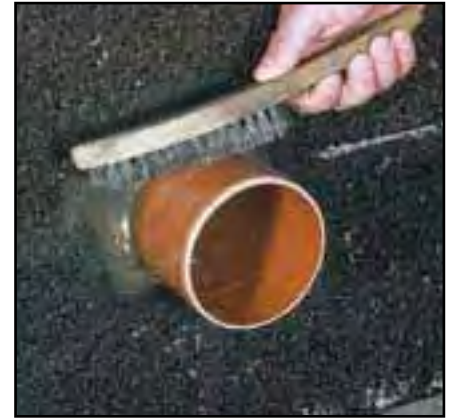
2 Po stwardnieniu zaokrąglenia, powierzchni rury nadać szorstkość za pomocą szczotki drucianej lub używając grubego papieru ściernego.
