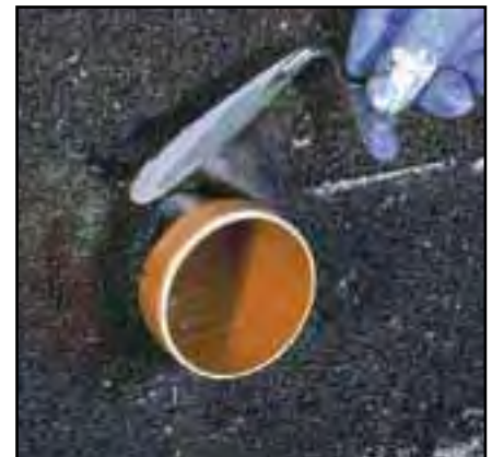
4 Po wyschnięciu podkładu nałożyć, w dwóch warstwach, bitumiczną masę uszczelniającą ( Sopro KSP 652 lub Sopro KD 754 ).
