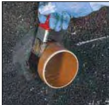
3 Aby zagwarantować grubowarstwową zaprawie bitumicznej lepsze przyleganie do rury, nanieść podkład gruntujący bitumiczny Sopro BVA 759 lub Sopro KDG 751 , używając pędzla.
