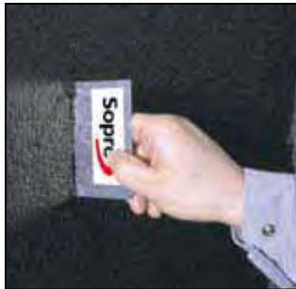
1 Grubość pojedynczych warstw mierzona jest odpowiednim miernikiem w warstwie wilgotnej.
