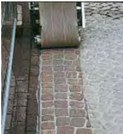
Czyszczenie dużych powierzchni przy pomocy maszyny zmywającej.
