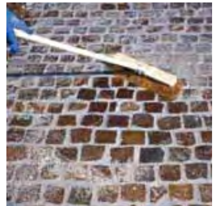
Czyszczenie gotowej okładziny z wypełnionymi spoinami.
