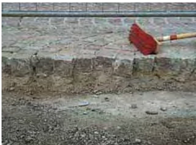
Kostka brukowa granitowa, układana w zaprawie hydraulicznie wiążącej (chudy beton).
