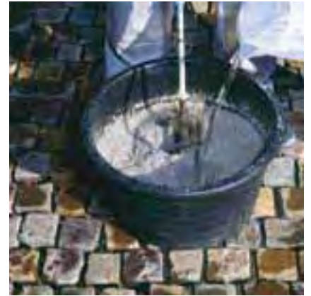
Mieszanie dwuskładnikowej fugi epoksydowej do kostki brukowej z dodatkiem wody.
