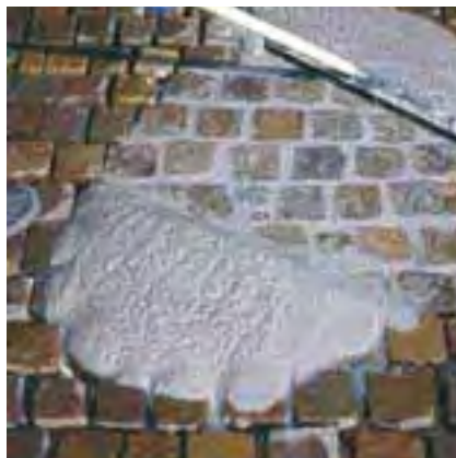
Wypełnianie szczelin zaprawą.
