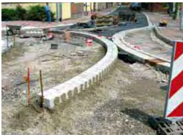
Płyty brukowe betonowe układane w betonowej warstwie nośnej.
