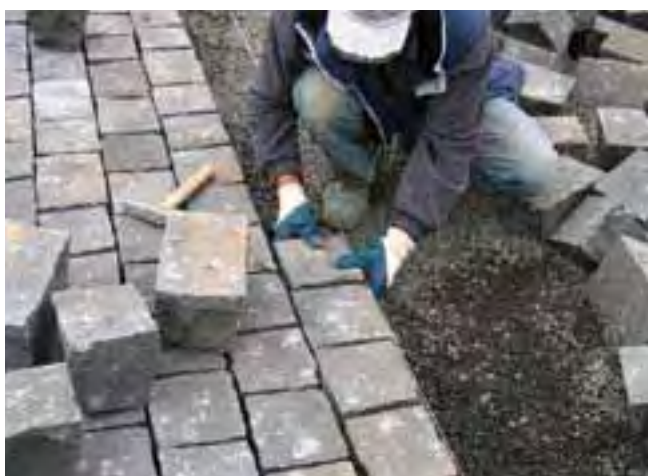
Okładzina brukowa z kamienia naturalnego o wysokiej wytrzymałości, na odcinkach dróg o wzmożonym ruchu.
