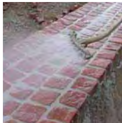
Czyszczenie powierzchni po związaniu zaprawy fugowej mgiełką wodną.
