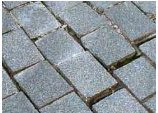
Przesunięta okładzina na skutek brakującego wypełnienia i odpowiednio wysokich obciążeń użytkowyc.
