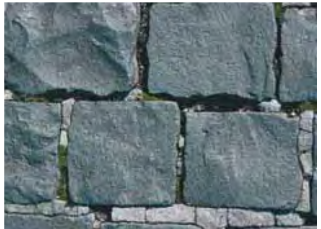
Zniszczona fuga, jako efekt kombinacji sztywnego wypełnienia i elastycznego podłoża przy wysokich obciążeniach użytkowyc.
