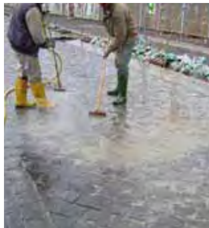
Czyszczenie mgiełką wodną.
