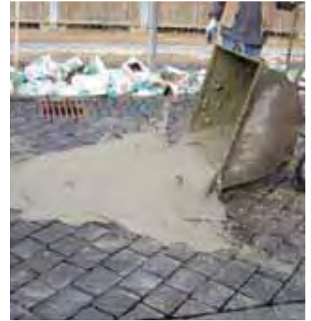
Proste wypełnianie spoin dzięki doskonałej rozlewności zaprawy fugowej.
