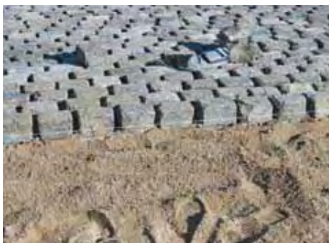
Układanie kostki brukowej z elastyczną podbudową, na podłożu żwirowo-piaskowym.
