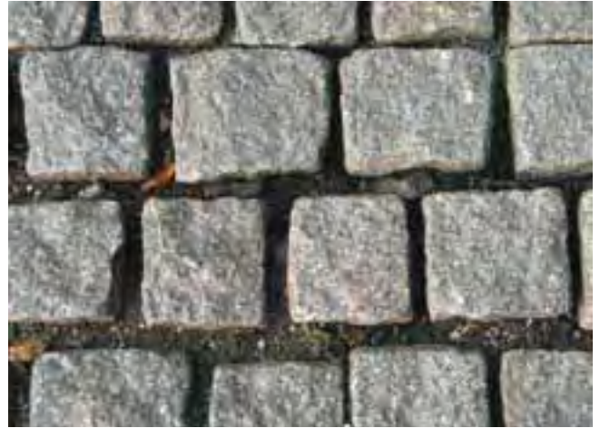
Wyplukane wypełnienie na skutek czyszczenia mechanicznego.
