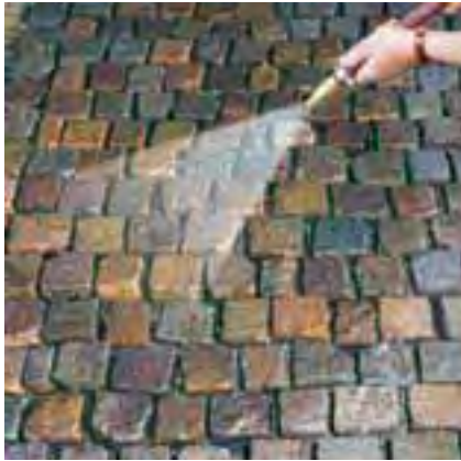
Nawilżanie wyczyszczonej okładziny, która ma być wypełniona zaprawą fugową.
