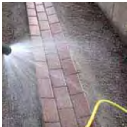
Dokładne nawilżenie rynny z betonowej kostki brukowej.
