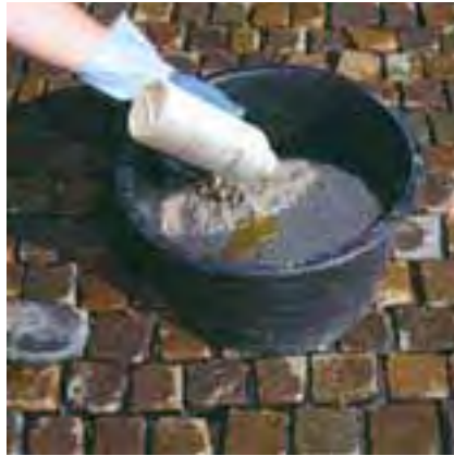
Dodanie utwardzacza do mieszanki piasku kwarcowego nasyczonego żywicą.
