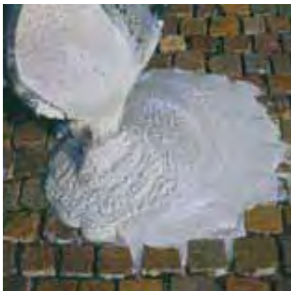
Nanoszenie dwuskładnikowej fugi epoksydowej do kostki brukowej.
