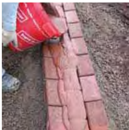
Nanoszenie dopasowanej kolorystycznie trasowej zaprawy fugowej do kamienia naturalnego Sopro TNF.
