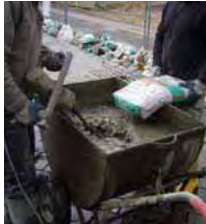
Mieszanie zaprawy fugowej mieszadłem.
