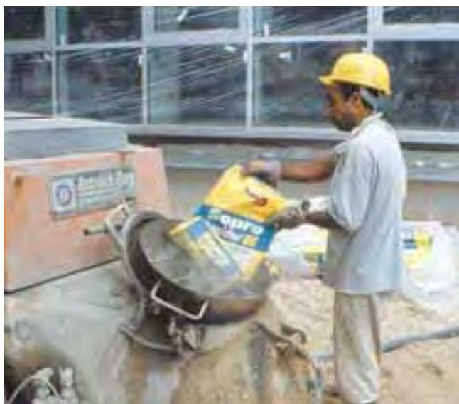
Łatwa obróbka spoiwa szybkowiążącego Sopro Rapidur® B5, poprzez dozowanie w trakcie mieszania na miejscu budowy.
