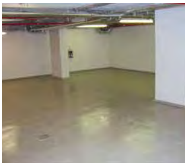
Pokrycie podłogi wykonane przy pomocy farby epoksydowej do betonu - wysokowytrzymałej SoproDur® HF-L.
