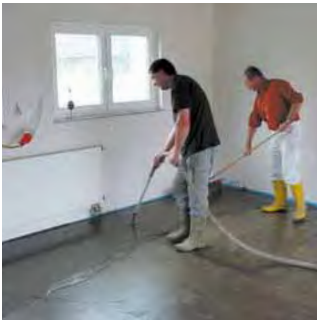
Łatwe maszynowe nanoszenie szpachli samopoziomującej wysokowytrzymałej, SoproDur® HF-S.
