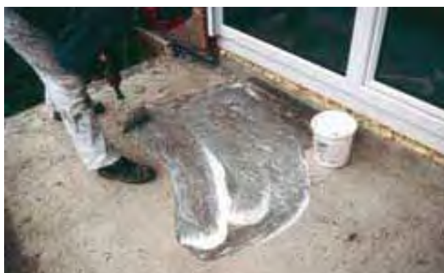
Przygotowanie podłoża emulsją przyczepną Sopro HE 449 metodą „świeżo na świeżo”.
