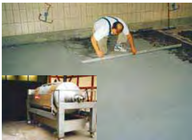
Bardzo wytrzymałe konstrukcje z epoksydowego jastrychu (wiążącego z podłożem) dla uzyskania powierzchni wytrzymałej na obciążenia punktowe.
