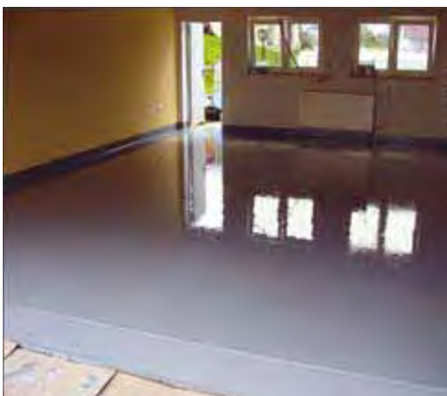
Powierzchnia garażu wykończona farbą epoksydową do betonu - wysokowytrzymałą SoproDur® HF-L.
