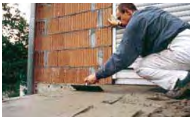
Wykonywanie powierzchni spadkowej przy pomocy szpachli wyrównawczej Sopro.
