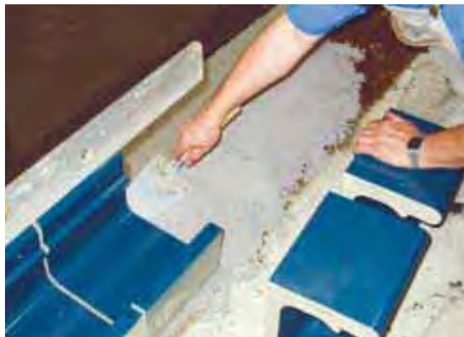
Układanie kształtek basenowych za pomocą szpachli epoksydowej Sopro.
