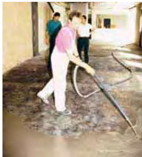
Na dużych powierzchniach istnieje możliwość nakładania masy szpachlowej przy pomocy agregatu.
