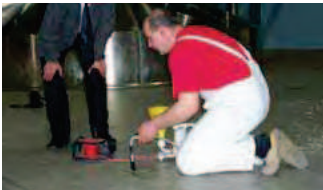
Wstrzykiwanie za pomocą techniki iniekcyjnej (15 barów).
