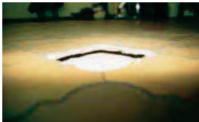
Pustki pod okładziną ceramiczną.
