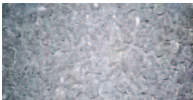
Porowaty jastrych cementowy z otwartymi porami.
