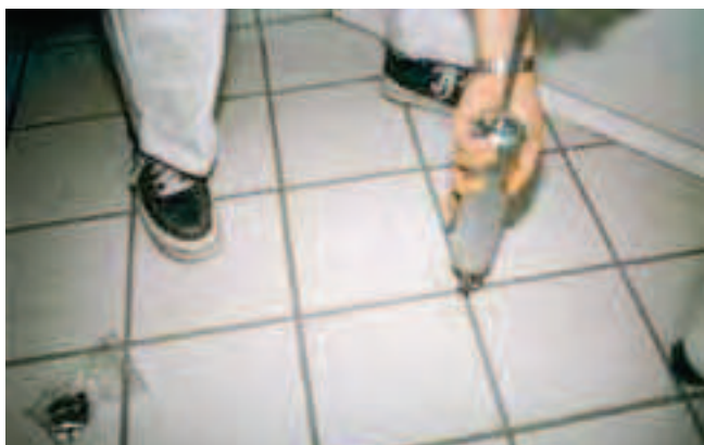
Wpompowywanie środka iniekcyjnego za pomocą pompki ręcznej, w przypadku małych powierzchni.
