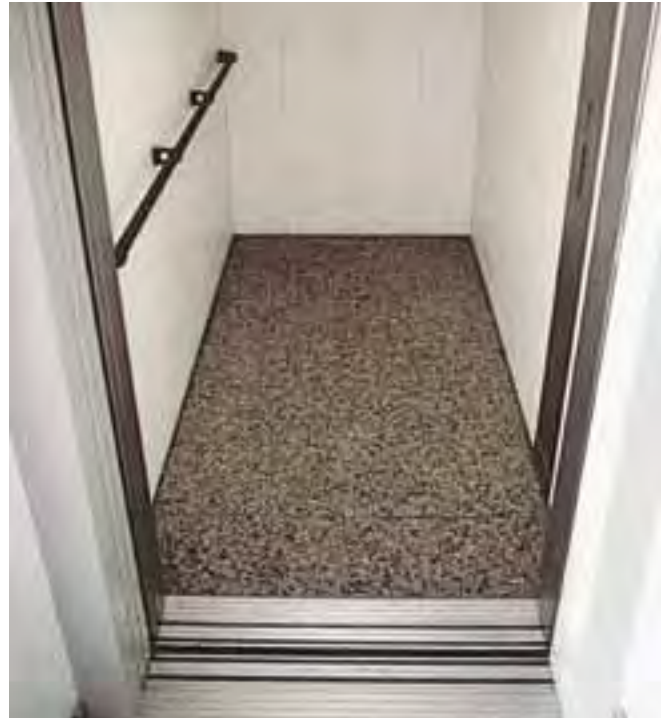
Winda z okładziną z kamienia naturalnego, ułożoną na stalowym podłożu.
