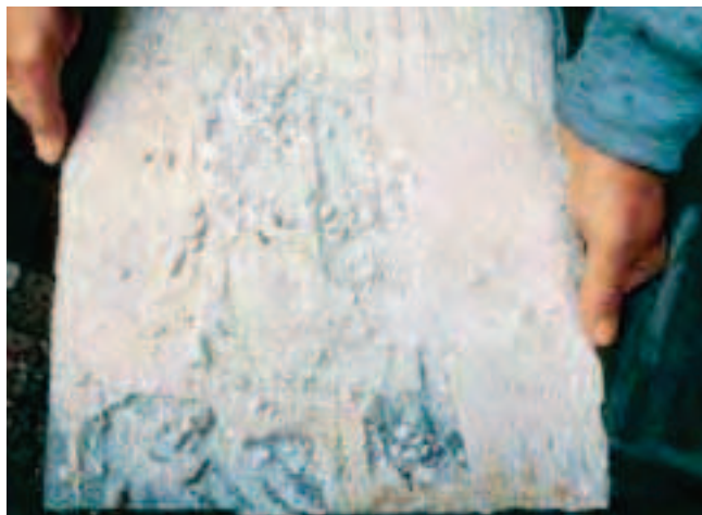
Uszkodzenie przyczepności poprzez tworzenie się etryngitu.
