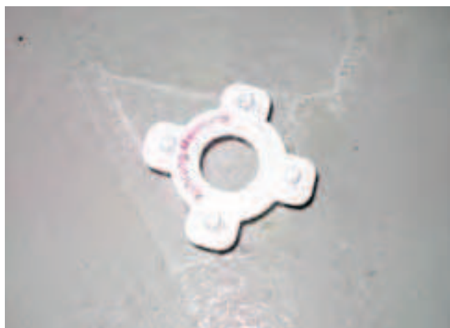
Zaznaczanie miejsc pomiaru na ogrzewanym jastrychu, celem uniknięcia uszkodzenia przy pomiarach aparatem CM.
