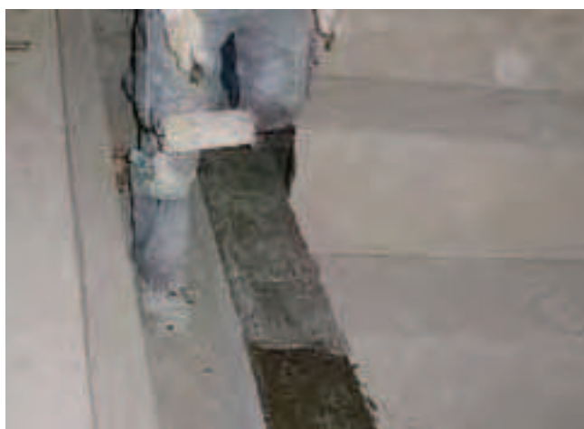
Nakładanie preparatu epoksydowego Sopro EPG jako mostka szepnego.
