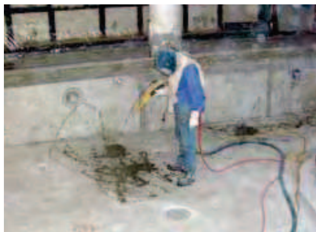
Piaskowanie betonu w celu uzyskania optymalnej, szorstkiej, nośnej powierzchni betonowej.
