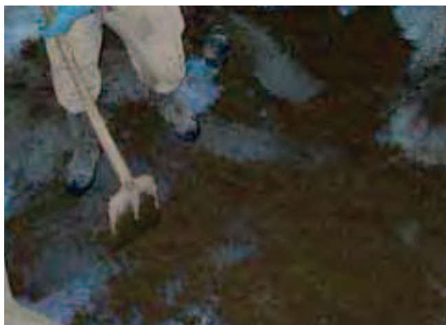
Tworzenie jastrychu zespolonego; nakładanie zaprawy jastrychowej na świeży mostek szepny.
