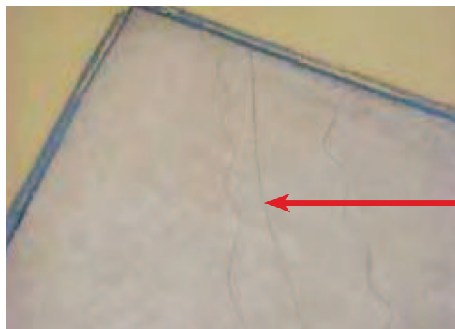
Spękany jastrych anhydrytowy na skutek skurczu podczas procesu schnięcia.
