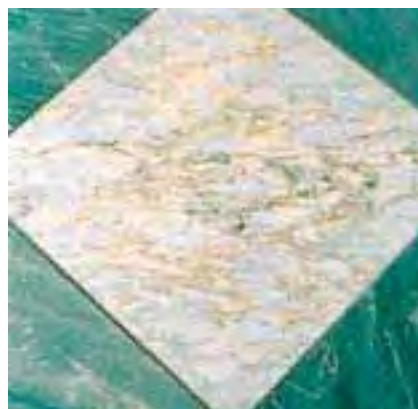
Przebarwienia spowodowane znajdującymi się w kamieniu naturalnym minerałami oraz doprowadzoną wodą (np. przy układaniu metodą grubowarstwową).
