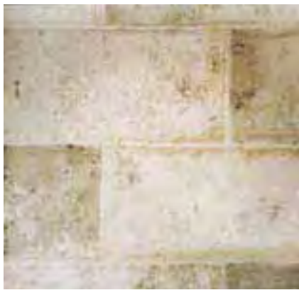
Przebarwienia kamienia naturalnego spowodowane podciąganiem wody.
