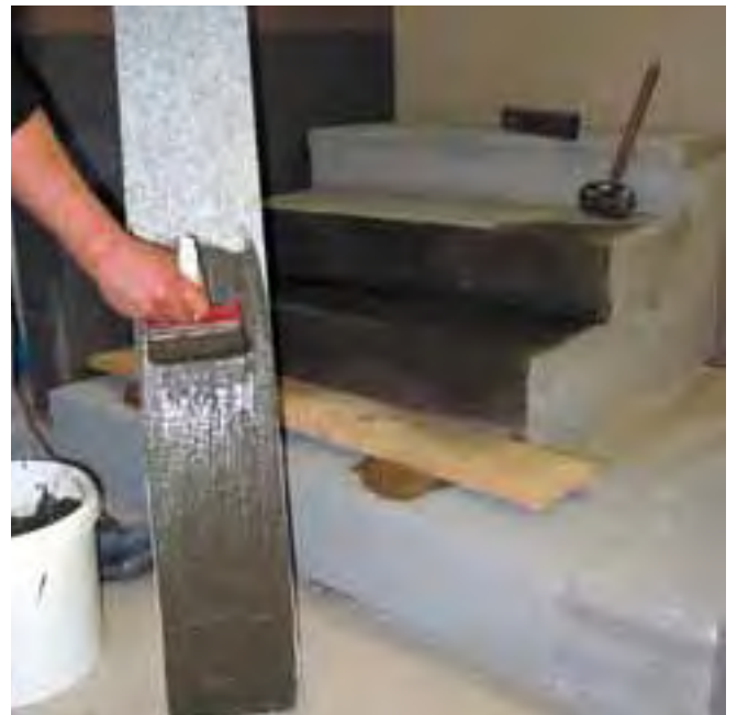
4 Przygotowanie okładziny poprzez naniesienie na spódnią stronę elementu elastycznej zaprawy kontaktowej Sopro HSF 748 (wzgl. zaprawy uszczelniającej do marmuru Sopro MAS 418).
