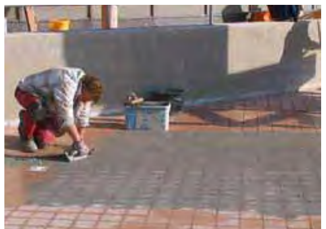
6 Fugowanie elastyczną, hydraulicznie wiążącą zaprawą fugową.
