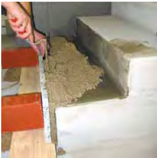
5 Montaż podstopnicy na zaprawie drenażowej Sopro DM 610.
