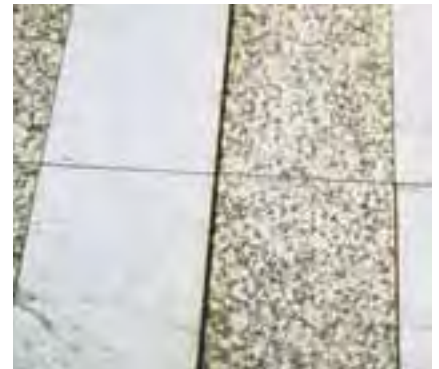
Przebarwienia kamienia naturalnego spowodowane niewłaściwym doбором silikonu do elastycznego wypełnienia spoin.
