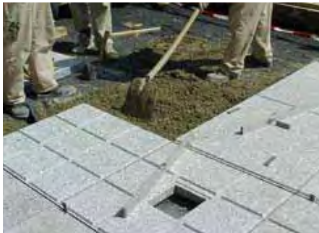
2 Rozkładanie zaprawy drenażowej Sopro do układania metodą grubowarstwową.
