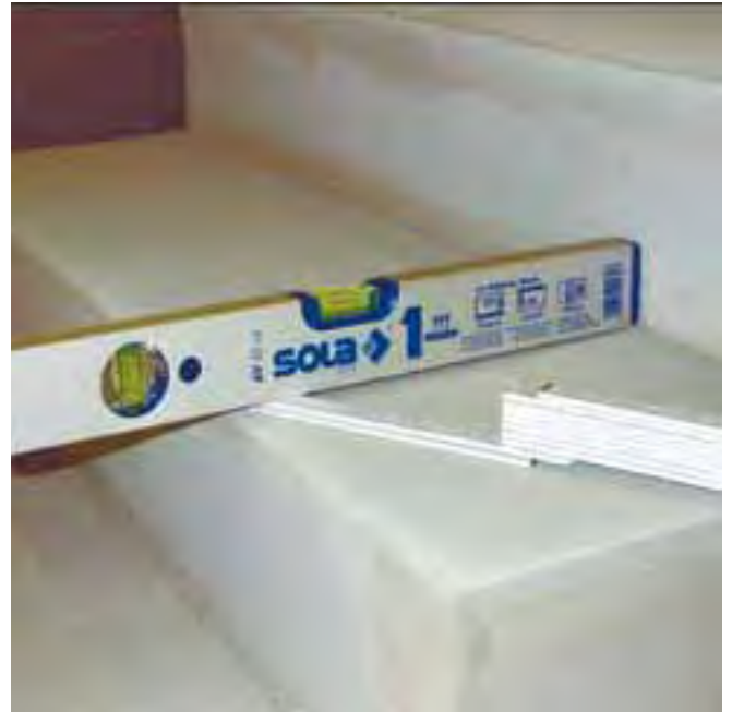
2 Bieg schodowy z wyprowadzonymi spadkami przygotowany do nałożenia kolejnej warstwy.
