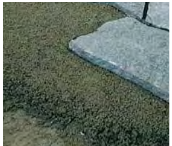
Układanie płyt z kamienia łamanego przy pomocy zaprawy drenażowej.
