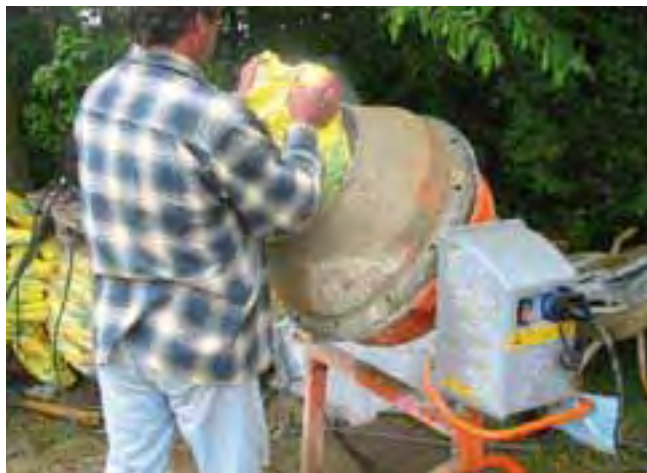
1 Mieszanie zaprawy drenażowej Sopro DM 610 w betoniarnie wolnostopowej.
