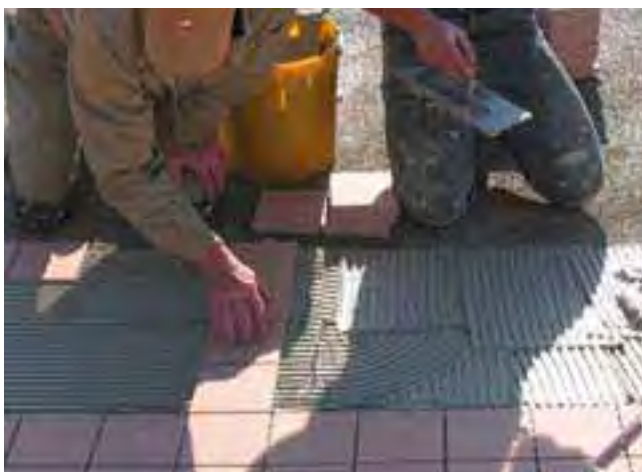
5 Układanie płytek metodą cienkowarstwową na jastrychu drenażowym.
