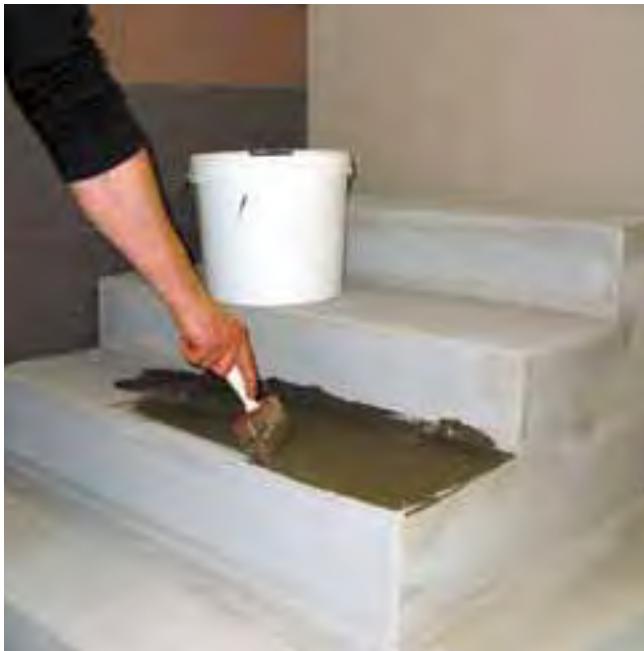
3 Nanoszenie Sopro HSF 748 jako warstwy kontaktowej dla zaprawy drenażowej Sopro DM 610.
