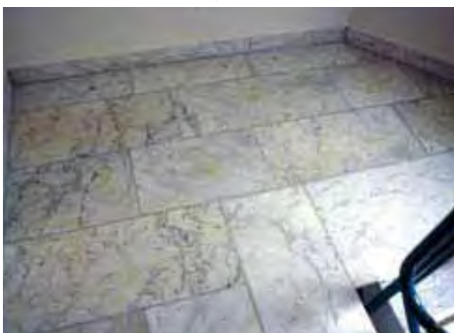
Żółte przebarwienia na kamieniu naturalnym, wywołane dużą wilgotnością zaprawy grubowarstwowej.
