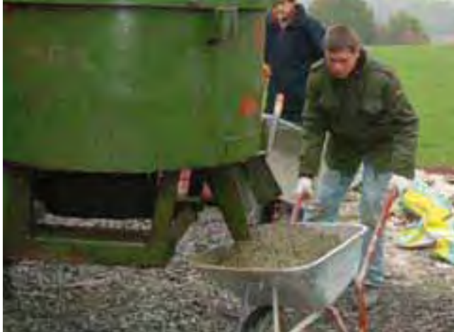
1 Mieszanie zaprawy betoniarką przeciwbieżną lub pompą do jastrychu.
