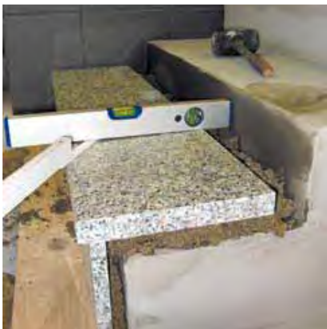
7 Gotowy stopień ułożony na zaprawie drenażowej.
