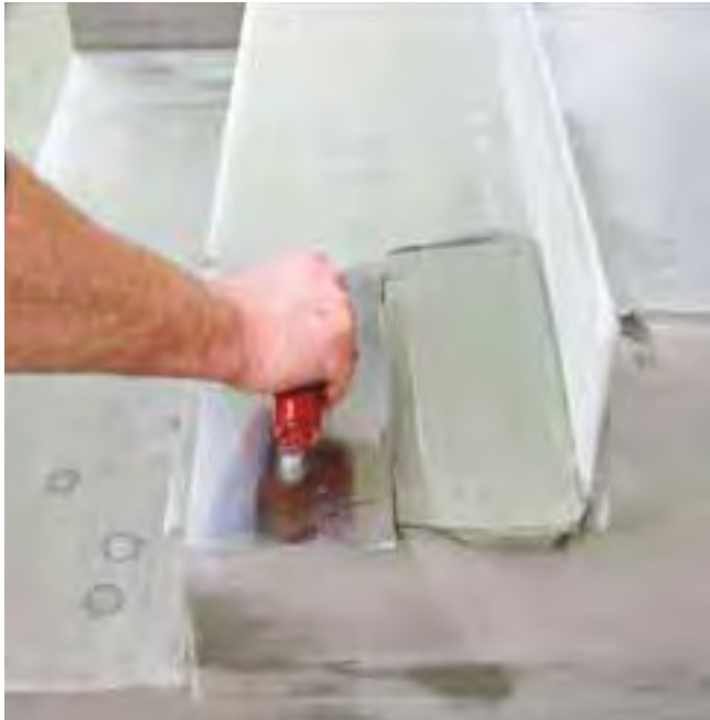
1 Wyprowadzenie spadku na stopniach za pomocą zaprawy wyrównującej Sopro AMT 468.
