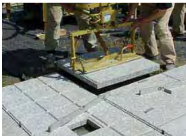
3 Układanie płyt metodą grubowarstwową. Zaprawa kontaktowa Sopro HFS 748 została wcześniej naniesiona na spód płyty.
