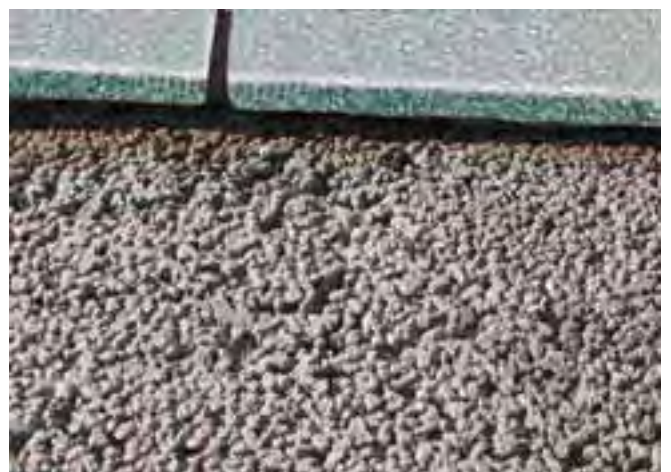
4 Związana konstrukcja z jastrychu drenażowego, o otwartej wodoprzepuszczalnej strukturze.
