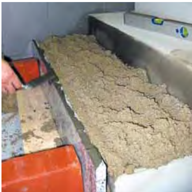
6 Warstwa zaprawy drenażowej przygotowana do montażu stopnicy.
