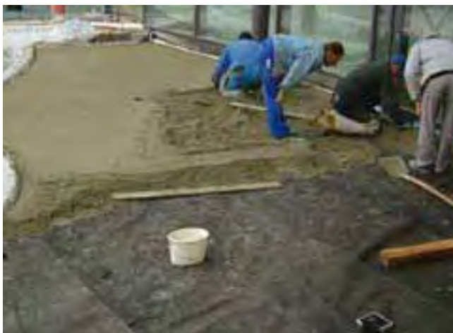
3 Tworzenie warstwy rozkładającej obciążenia przy użyciu zaprawy drenażowej Sopro DM.
