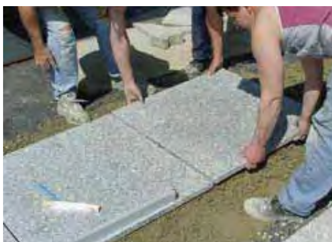
4 Ręczne układanie płyt metodą grubowarstwową (zaprawa drenażowa Sopro).
