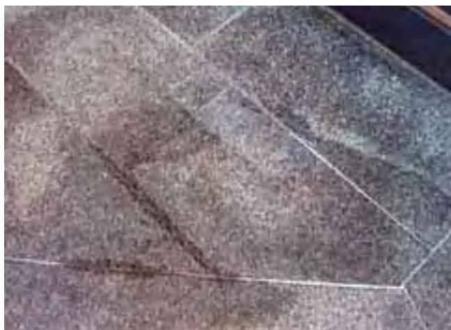
Przebarwienia powstałe na skutek przenikania wilgoci przez fugę.
