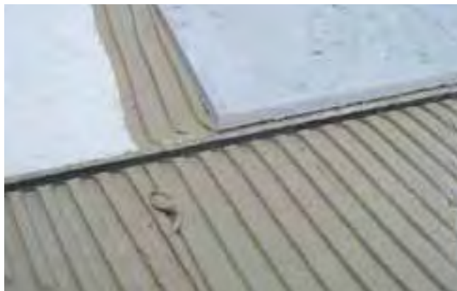
Płyty Sopro TDP 565 ułożone na podeście schodów jako wygłuszenie pod okładziną z kamienia naturalnego.
