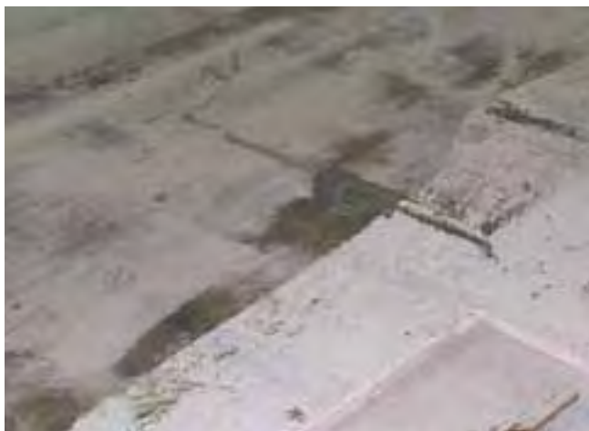
1 Gruntowanie podłoża chłonnego.
