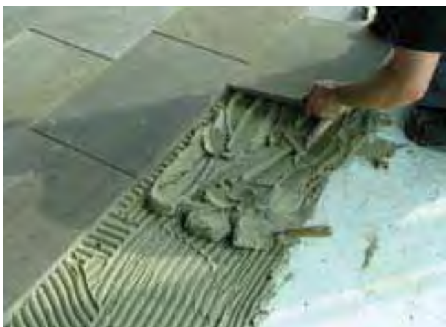
3 Układanie okładziny z kamienia naturalnego metodą średniowarstwową przy użyciu zaprawy klejowej elastycznej z traselem Sopro TR.
