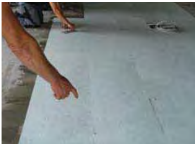
2 Układanie płyt izolacyjnych Sopro FDP 558 oddzielających okładzinę wierzchnią (kamień naturalny) od podłoża.
