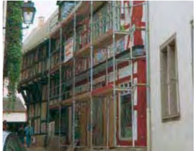
Remonty starych budowli.
