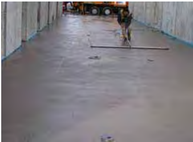
Niewysezonowany beton na terminalu lotniczym.
