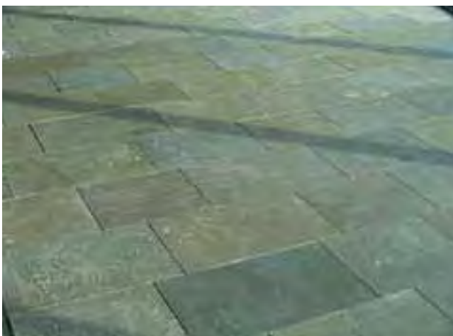
4 Powierzchnia z gotową okładziną.
