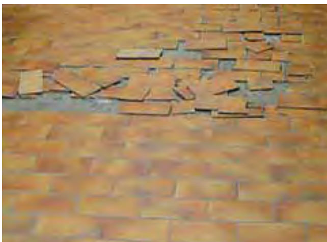
Odpadanie płytek na skutek ułożenia okładziny na zbyt młodym betonie.
