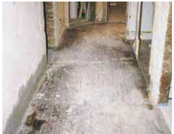
Podłoga z desek jako podłoże pod płytki ceramiczne.
