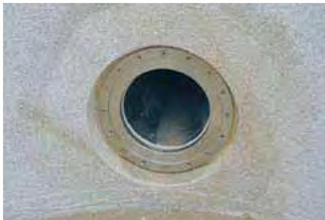
Wzorcowe podłączenie uszczelnienia do obudowy reflektora z kołnierzem uszczelniającym w obszarze pod wodą.
