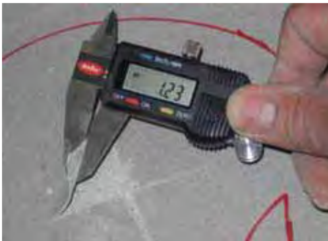
9 Kontrola łącznej grubości uszczelnienia zespolonego.
