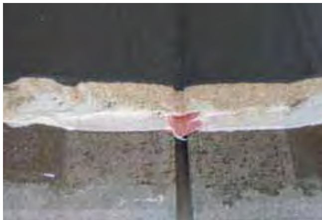
Dylatacja konstrukcyjna z dwoma warstwami taśmy uszczelniającej, zatopionej w elastycznej powłoce uszczelniającej Sopro PU-FD, następnie pokryta właściwym uszczelnieniem zespolonym.
