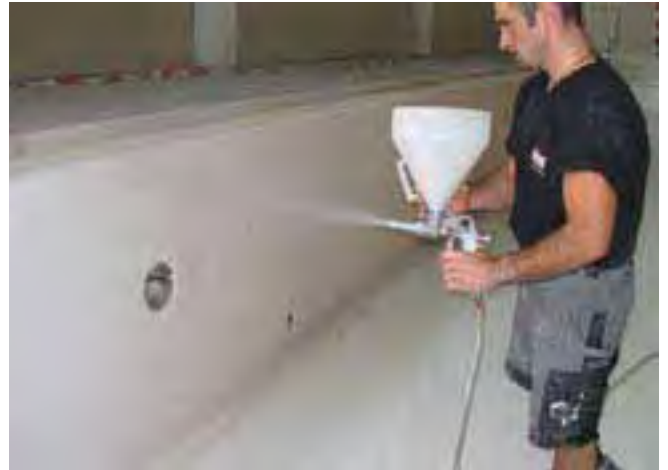
8 Wykonywanie posypki z piasku kwarcowego metodą mechaniczną na ścianie Sopro PU-FD 570.
