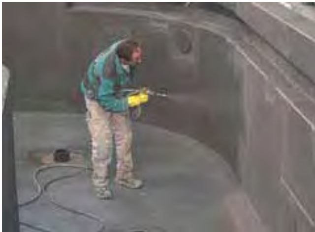
1 Nakładanie elastycznej zaprawy uszczelniającej Sopro DSF 523 w co najmniej dwóch warstwach metodą natryskową.
