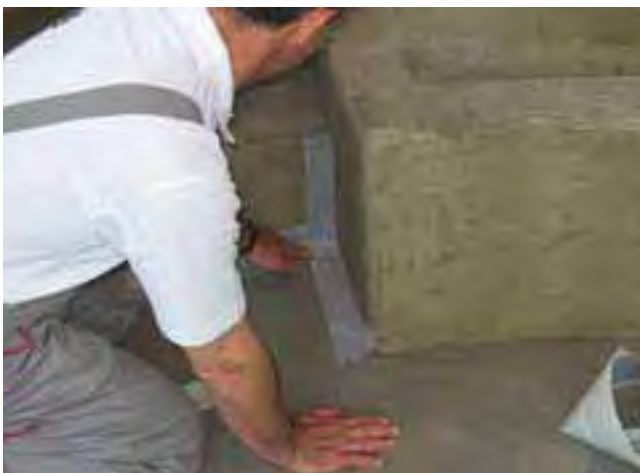
4 Naklejanie samoprzylepnej taśmy uszczelniającej.
