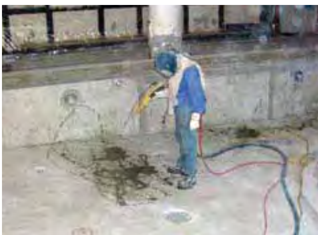
Piaskowanie betonu.
