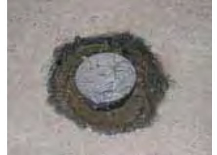
Materiał rozpinający w podłożu do wypełnienia klejem antykapilarnym.
