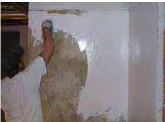
6 Uszczelnianie powierzchni ścian przy użyciu elastycznej powłoki uszczelniającej do ścian Sopro PU-FD 570.
