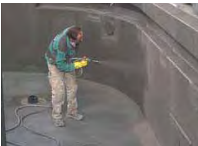
Nakładanie uszczelnienia zespolonego (Sopro DSF) metodą natryskową.
