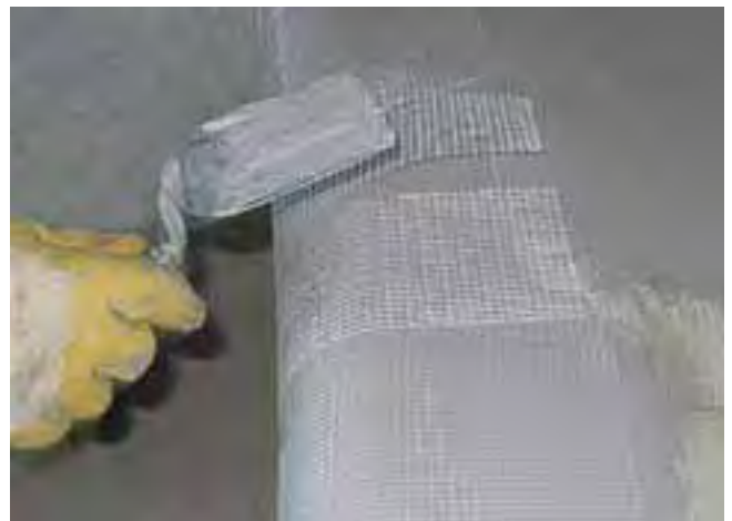
Zastosowanie siatki z włókna szklanego jako wzmocnienia uszczelnienia zespolonego.
