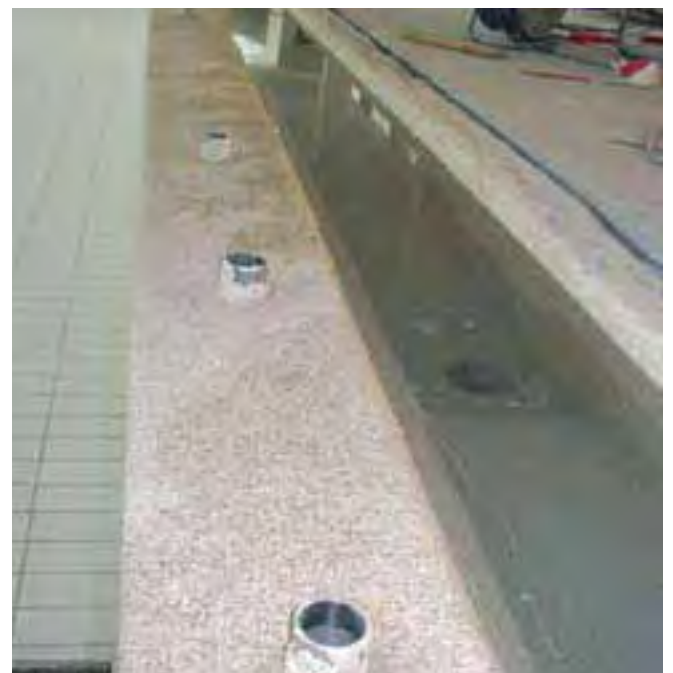
Tuleje w niecce do późniejszego zamontowania drabinki.
