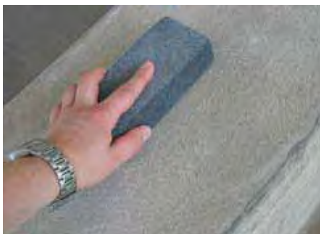
3 Obróbka suchej powierzchni z posypką przy użyciu kształtki korundowej.
