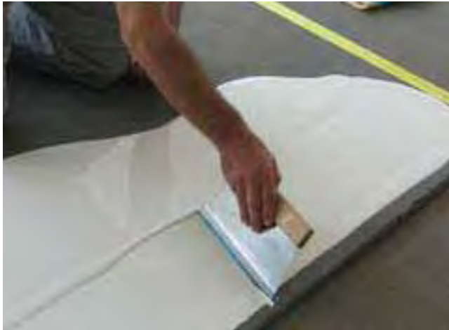
7 Uszczelnianie podłogi przy użyciu Sopro PU-FD 571.
