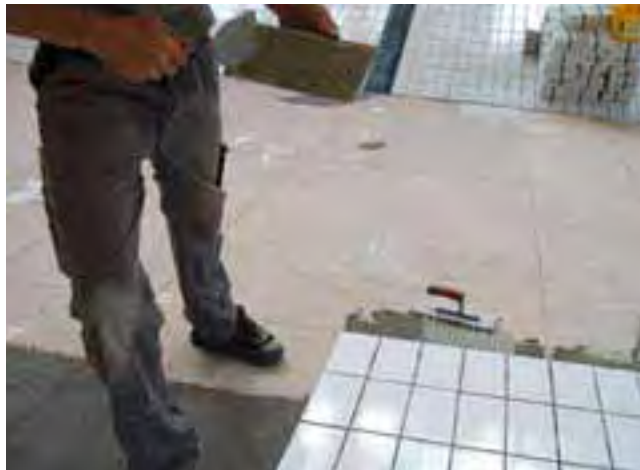
3 Po przebytej pozytywnie próbie wodnej, klejenie płytek hydraulicznie wiążącym klejem elastycznym, metodą kombinowaną.
