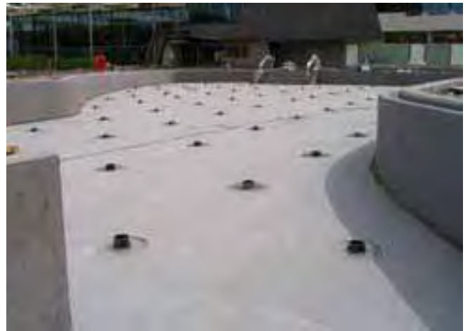
2 Niecka basenowa uszczelniona elastyczną zaprawą uszczelniającą Sopro DSF 523 przed próbą wodną.
