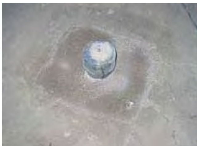
Przepust podłogowy zalany antykapilarnie mieszanką preparatu epoksydowego Sopro EPG i piasku kwarcowego.
