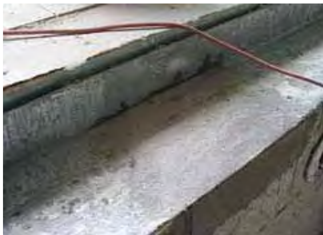
Skrzynka odpływowa pokryta żywicą reaktywną i siatką.
