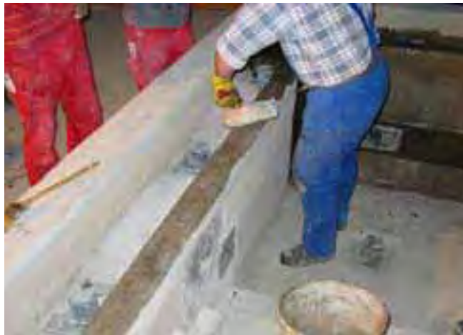
1 Gruntowanie powierzchni przy użyciu preparatu epoksydowego Sopro EPG. Zużycie zależy od chłonności podłoża.
