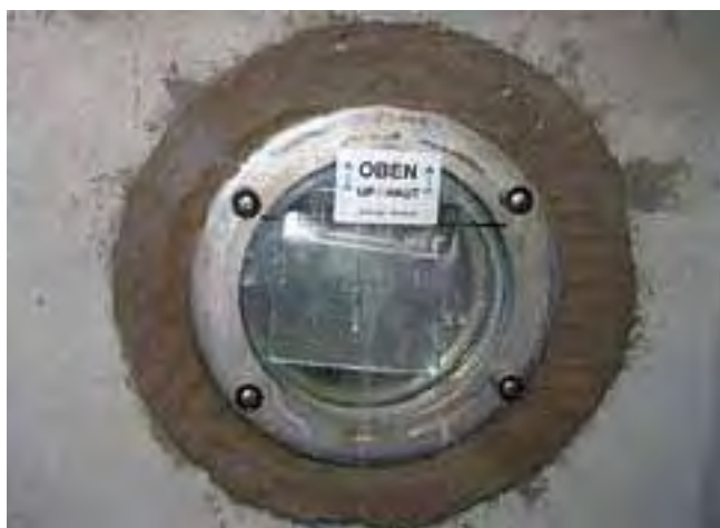
Obudowa reflektora zaszpachlowana antykapilarnie przy użyciu Sopro DBE.
