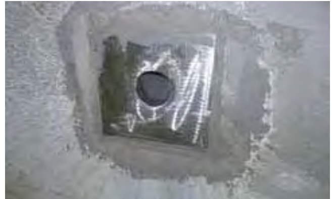
Kołnierz z metalu, wolny od tłuszczu i substancji oleistych, mechanicznie zmatowiony, przygotowany do następnych prac.
