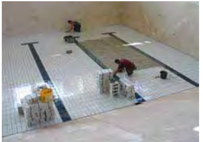
4 Fugowanie okładziny wysokowytrzymałą fugą SoproDur® HF 8.
