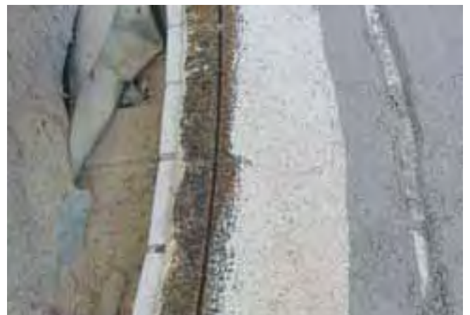
Wyźłobienie w niecce basenowej do uszczelnienia na powierzchni niecki.
