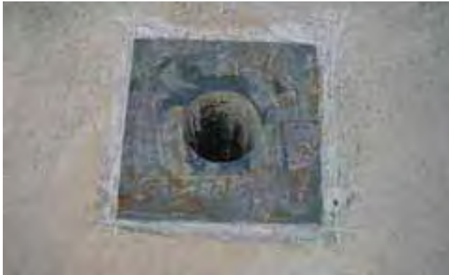
Kołnierz z tworzywa sztucznego, wolny od tłuszczu i substancji oleistych, mechanicznie zmatowiony, przygotowany do następnych prac.
