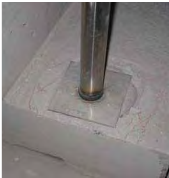
Słupek na schodach z kołnierzem montażowym.
