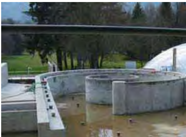
Niecka betonowa – stan surowy.
