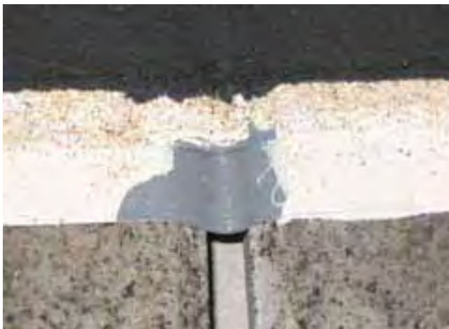
Uszczelnianie szczeliny w konstrukcji dwuwarstwowej taśmą uszczelniającą, zatopioną w elastycznej powłoce uszczelniającej Sopro PU-FD.
