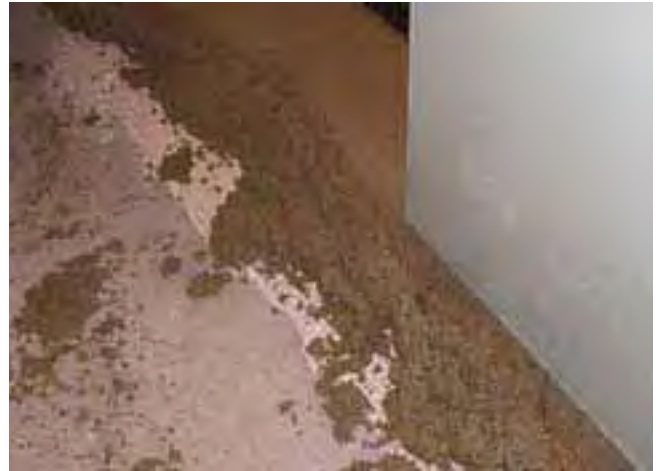
Nakładania jastrychu zespolonego np. z klejem elastycznym jako mostkiem szelnym.
