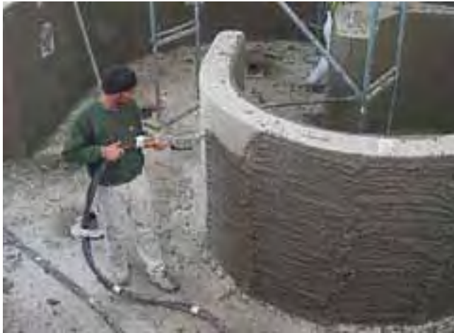
Tynkowanie/szpachlowanie ścian niecki.
