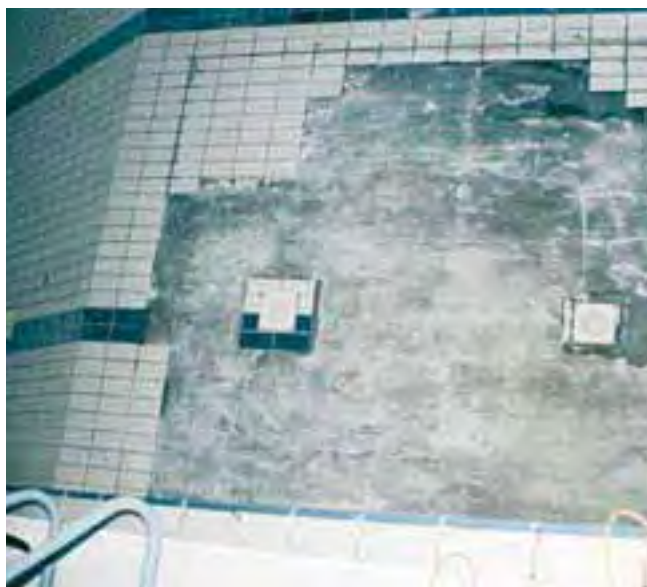
Utrata przyczepności spowodowana zbyt cienką warstwą uszczelnienia.
