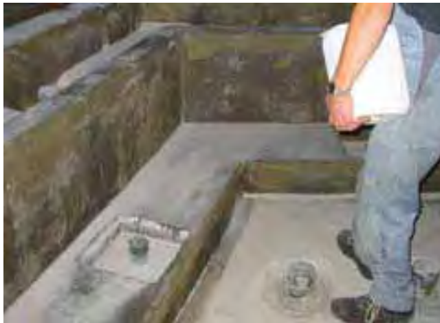
2 Wykonywanie posypki z piasku kwarcowego na świeżej warstwie preparatu epoksydowego Sopro EPG.
