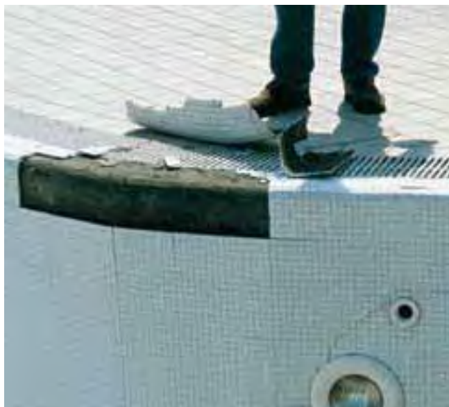
Przyczyna utraty przyczepności w obszarze reflektora.
