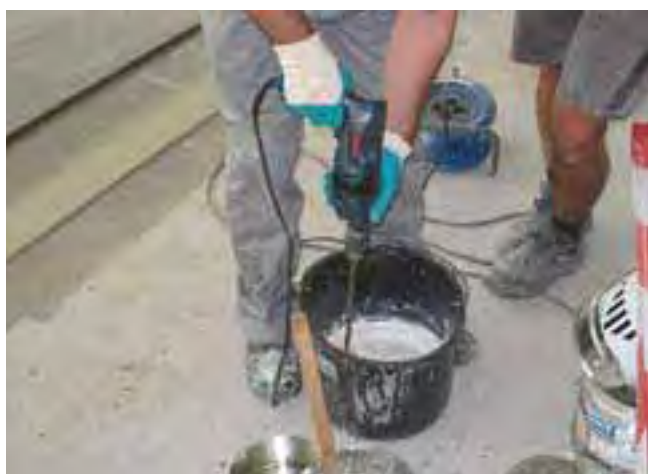
5 Dokładne wymieszanie elastycznej powłoki uszczelniającej Sopro PU-FD.
