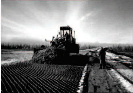
Rys. 8. Zасыpywanie kruszywem komórek geosiatki za pomocą ładowarki
