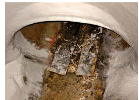
12. Przepiek został usunięty i zabezpieczony
