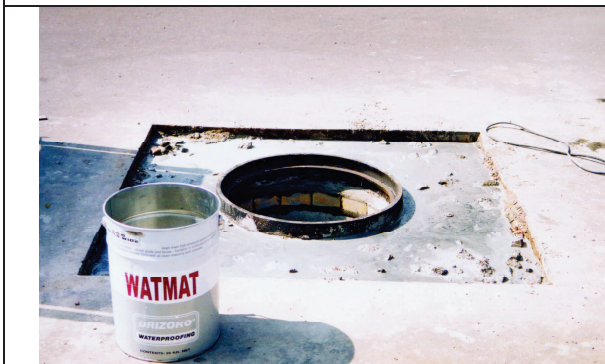
15. Zalany wjazd płynną zaprawą
