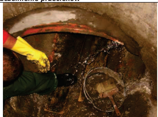
9. Uszczelnienie przecieków
