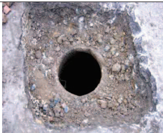
2. Gotowe miejsce naprawy zarwanego włazu
