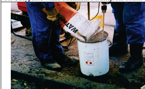
13. Przygotowanie płynnej zaprawy szybkosprawnej
