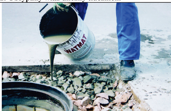
14. Zalanie tłucznia płynną zaprawą szybkosprawną
