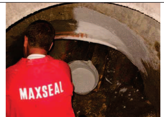
11. Zabezpieczenie powłoką Maxseal Flex
