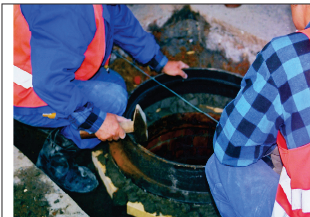
9. Wypoziomowanie pierścienia wjazdu ulicznego
