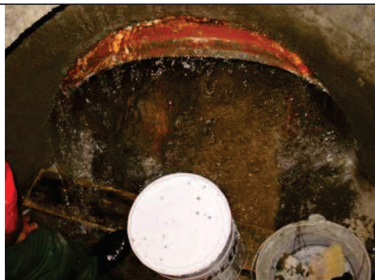
3. Miejsce przecieku oczyszczone i przygotowane do naprawy
