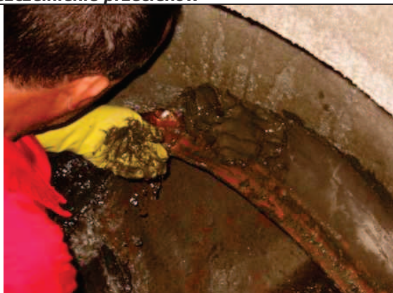
7. Uszczelnienie przecieków
