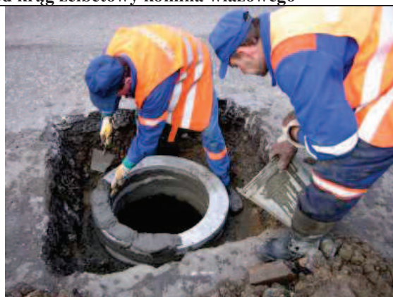
6. Układanie kolejnej warstwy zaprawy szybkosprawnej pod kręgi żelbetowe komina włazowego
