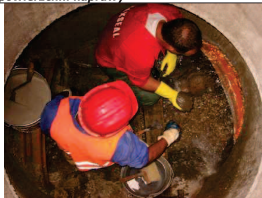
4. Przygotowanie Maxplug do aplikacji
