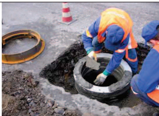
7. Wyrównanie zaprawy szybkosprawnej komina włazowego
