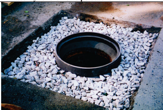
12. Obsypany wjazd uliczny tłuczniem
