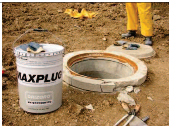
1. Remont studzienki kanalizacyjnej
