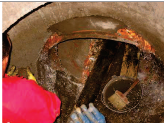
6. Uszczelnienie przecieków
