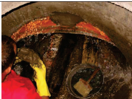
5. Uszczelnienie przecieków
