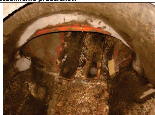
10. Przepiek został całkowicie uszczelniony
