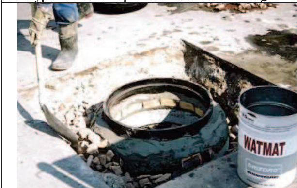
11. Obsypanie wjazdu tłuczniem o frakcji ok. 60mm
