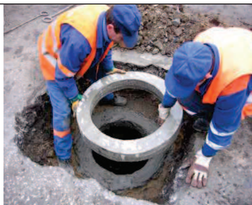
5. Osadzanie kręgu żelbetowego
