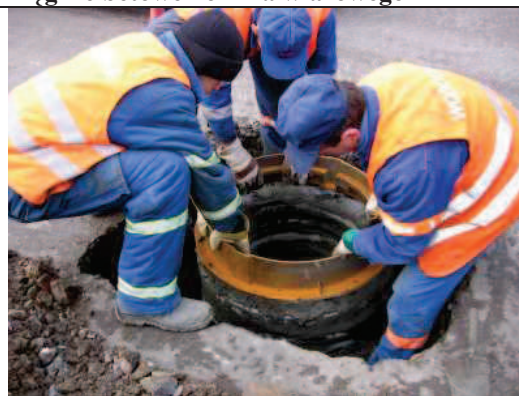
8. Osadzanie pierścienia stalowego włazu ulicznego
