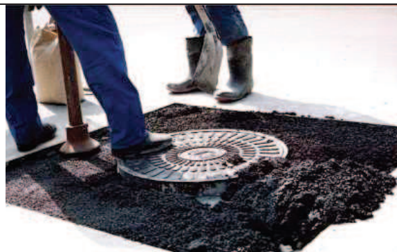
16. Układanie po 1 h masy asfaltowej
