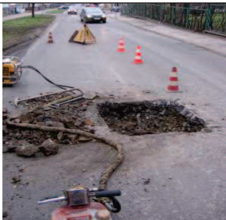
1. Rozkucie nawierzchni wokół włazu kanalizacyjnego
