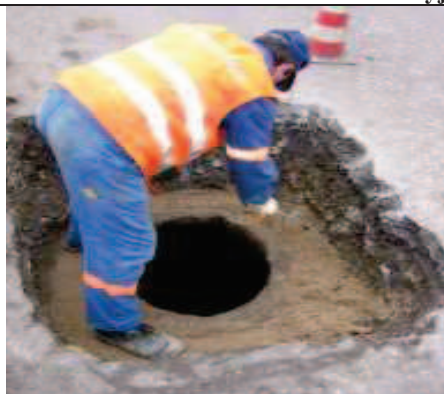
3. Oczyszczenie powierzchni wokół włazu kanalizacyjnego
