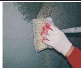
2. **MAXSEAL FLEX** – elastyczna powłoka mineralna na powierzchni betonowe
