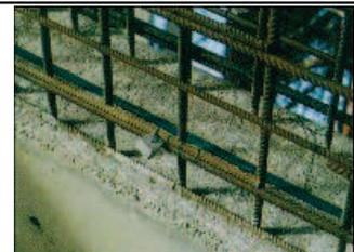
Uszczelnienie szwa roboczego w węźle ściana – płyta denna
