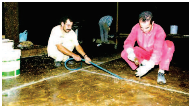
Układanie uszczelki pęczniejącej w istniejącej szczelinie dylatacyjnej.
