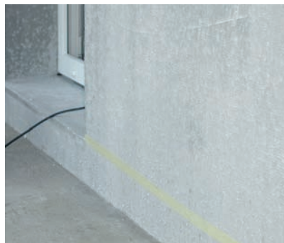
5. Aplikacja Sikaflex®-11 FC w celu zniwelowania przejścia pomiędzy pionem a poziomem.
