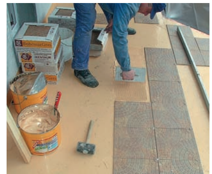
9. Po utwardzeniu się warstwy izolacyjnej (min. 20 godzin), nałożenie warstwy klejącej pacą grzebieniową
