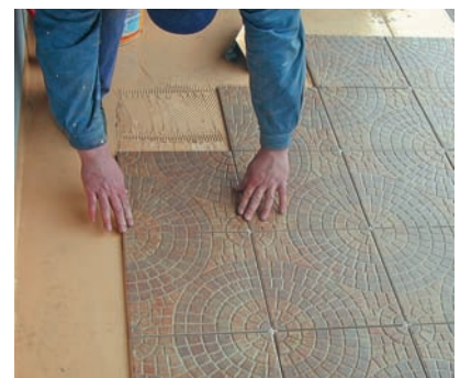
12. Wykonanie fugi z trwale elastycznego materiału poliuretanowego Sikaflex®-11 FC
