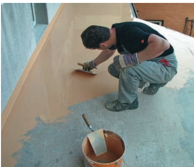
7. Aplikacja SikaBond®-T8 pacą gładką na podłożu
