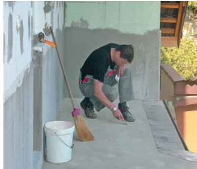
2. Oczyszczenie podłoża z luźnych związków i opylenie powierzchni. Gruntowanie jest niezalecane
