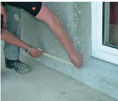
4. Oznaczenie górnej krawędzi cokołu
