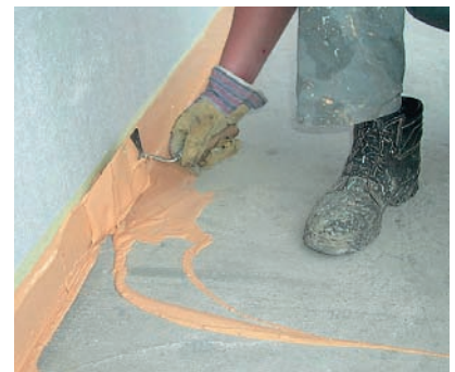
6. Izolacja przejścia pionu z poziomem materiałem SikaBond®-T8
