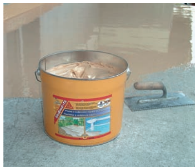
8. Warstwa izolacji: zużycie około 1 kg/m 2 . Warstwa izolacji musi mieć jednolitą, ciągłą strukturę.
