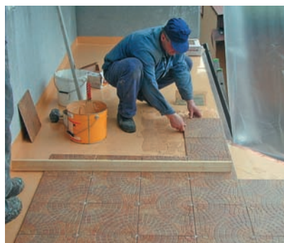
11. Ułożenie płytek ceramicznych
