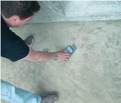
1. Przygotowanie suchego i równego podłoża
