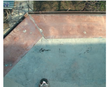
3. Odtłuszczenie i gruntowanie obróbki blacharskiej materiałem Sika®-Primer 3
