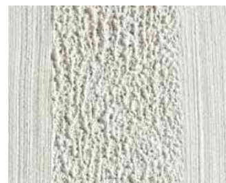
Połączenie efektów: szczotkowanie i wąłkowanie
