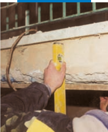
Naprawa gzymsów balkonowych
