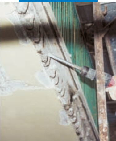
Naprawa gzymsów balkonowych: przygotowanie podłoża
