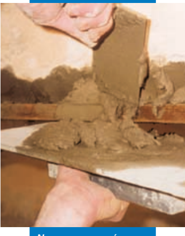
Naprawa gzymsów balkonowych: nanoszenie Planitop 400
