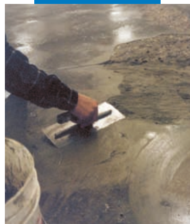
Naprawa podłogi betonowych w zakładach przemysłowych
