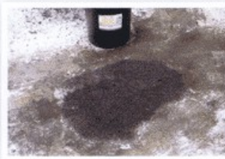
Po zagęszczeniu jezdni od razu gotowa jest do użytku
