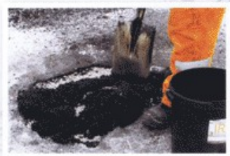
Drugą warstwę masy IRR rozprowadzamy np. łopatą
