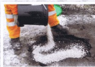
Wypełniamy kruszywem (np z wiadra po IRR)
