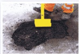
Zagęszczamy ubijakiem ręcznym lub mechanicznym
