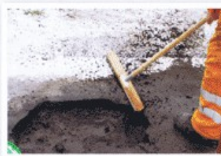
Oczyszczamy ubytek w jezdni
