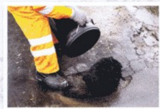
Wypełniamy ubytek prosto z poręcznego opakowania
