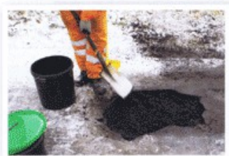
Rozprowadzamy prostym narzędziem tworząc warstwę ok 2cm
