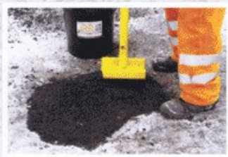
Zagęszczamy ubijakiem ręcznym lub mechanicznym
