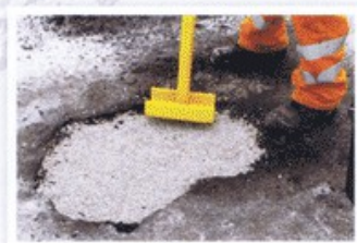
Zagęszczamy kruszywo pozostawiając 2cm na warstwę IRR
