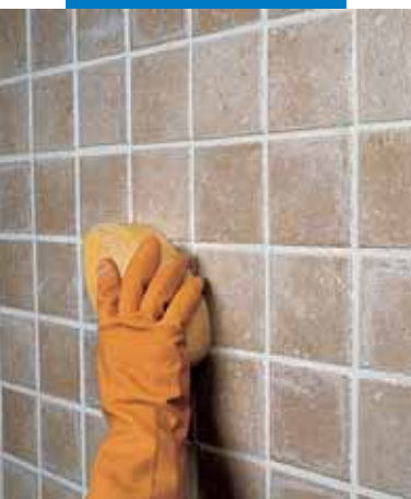
Czyszczenie płytek typu monocottura przy użyciu gąbki
