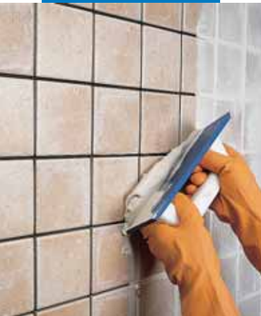
Spoinowanie płytek typu monocottura
