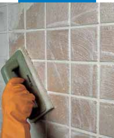
Czyszczenie płytek typu monocottura przy użyciu Scotch-Brite
