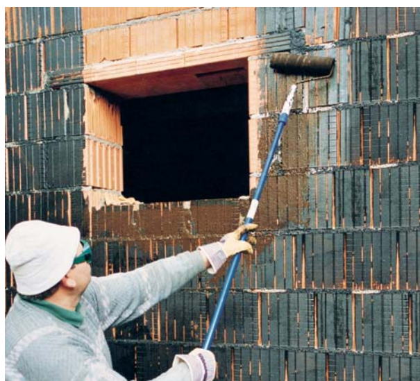
PCI Pecimor F, rozcieńczony wodą w stosunku 1:5, jako grunt do uszczelniania budowli za pomocą modyfikowanych tworzywem sztucznym bitumicznych powłok grubowarstwowych zgodnie z DIN 18 195.
