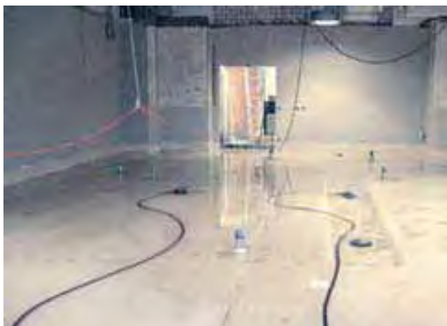
Sprawdzanie szczelności uszczelnienia podłogowego.
