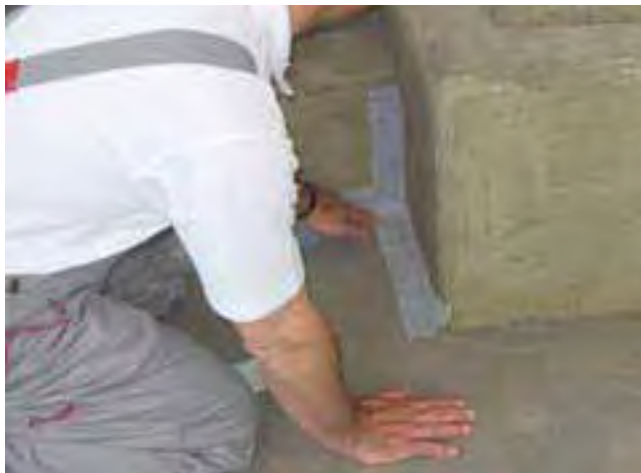
2 Naklejanie elastycznej taśmy uszczelniającej Sopro w obszarze fug dylatacyjnych.
