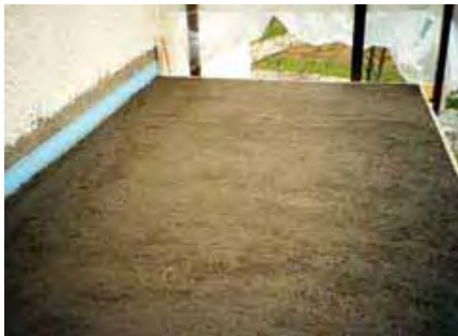
2 Powierzchnia ze spadkiem przygotowana do pokrycia uszczelnieniem zespolonym (Sopro DSF 523).
