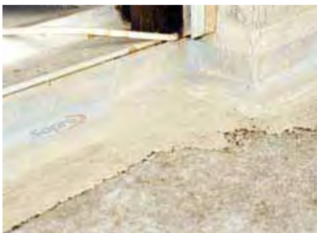
3 Wbudowywanie oraz mocowanie taśm uszczelniających i narożników przy użyciu zaprawy uszczelniającej Sopro DSF 523 na początku prac uszczelniających.
