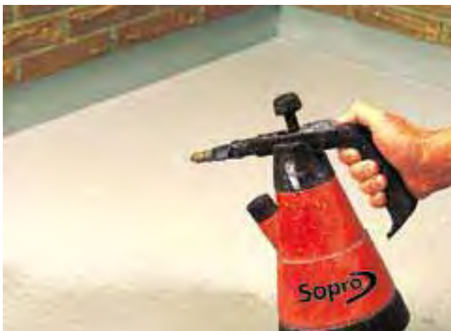
Lekkie zwilżenie podłoża przed zastosowaniem elastycznej zaprawy uszczelniającej.
