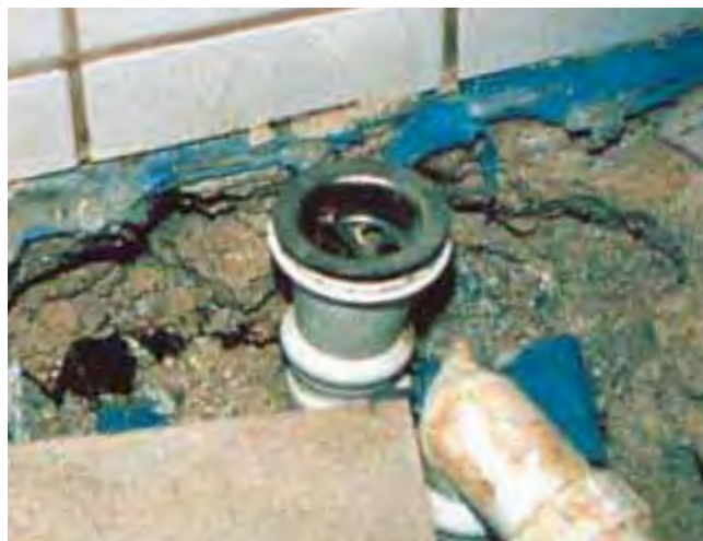
Nieszczelność powstała na skutek braku możliwości uszczelnienia kołnierza odpływu podłogowego.
