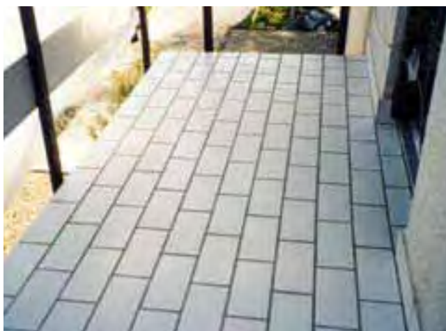
Balkon z okładziną ceramiczną.
