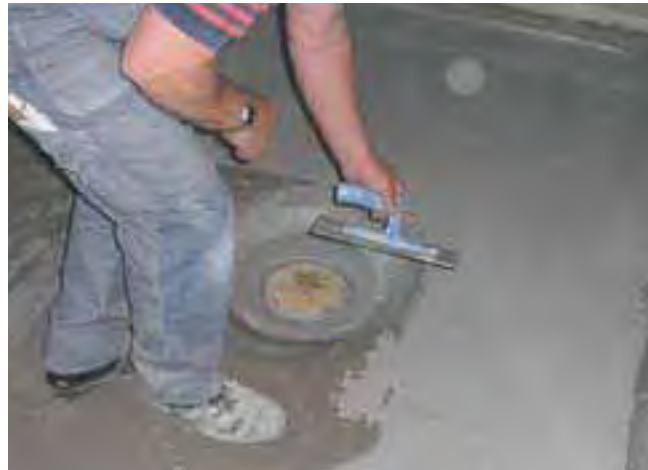
Nanoszenie elastycznej mineralnej zaprawy uszczelniającej.
