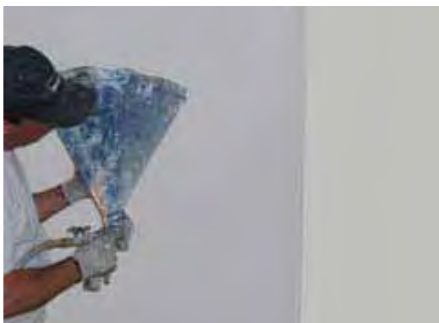
6 Nanoszenie piasku kwarcowego jako mostka szpepnego na świeżo położoną drugą warstwę elastycznej powłoki uszczelniającej Sopro PU-FD.
