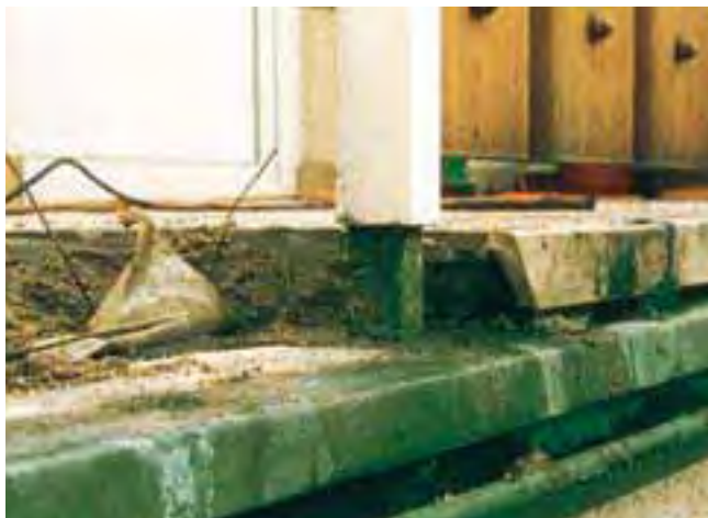
Jastrych, który utracił wytrzymałość z powodu stałego przepływu wody.
