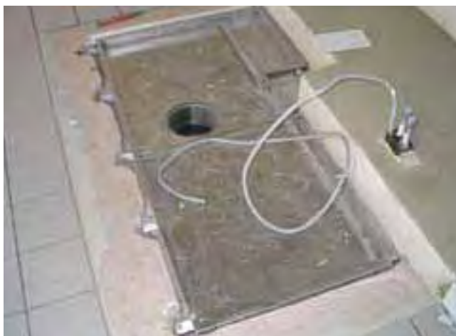
Rynienka osadzona w uszczelnionym wgłębieniu.
