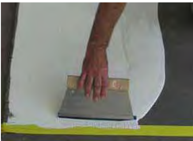
5 Nanoszenie elastycznej powłoki uszczelniającej Sopro PU-FD na podłogę w dwóch warstwach o łącznej grubości 1 mm.
