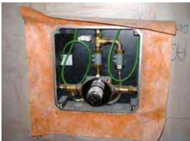
... lub z uszczelką do zatopienia w masie uszczelniającej.
