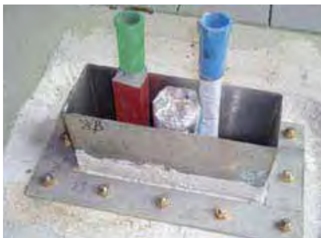
Rura instalacyjna z kołnierzem uszczelniona uszczelnieniem zespolonym.
