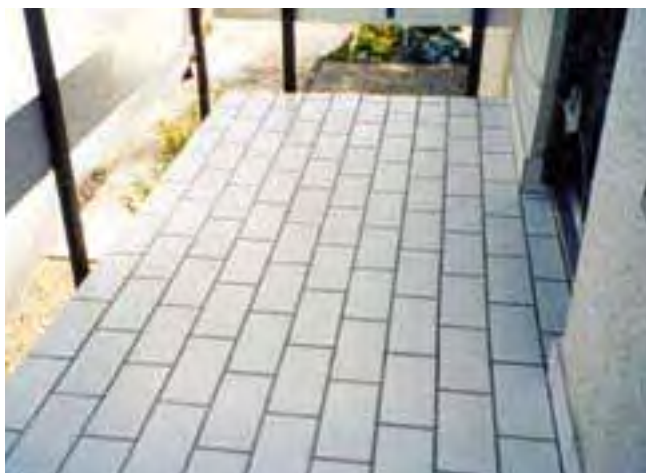
5 Płytki ułożone na wysoko elastycznej zaprawie cienkowarstwowej Sopro megaFlex S2 i spoinowane fugą elastyczną Sopro FL.
