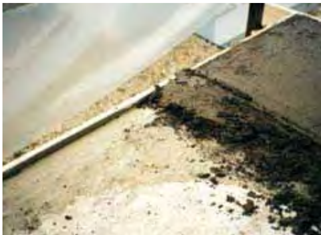
1 Nanoszenie szpachli spadkowej (Sopro AMT 468) lub jastrychu związanego z podłożem, metodą „świeżo na świeżo” z mostkiem szcypnym.
