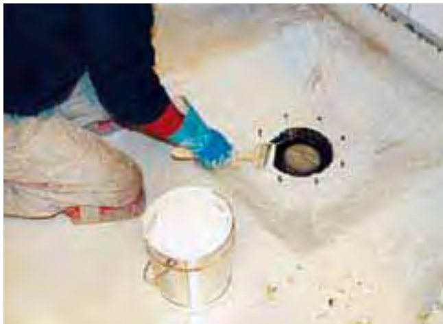
Przygotowanie elastycznej powłoki uszczelniającej Sopro PU FD i połączenie z kołnierzem.
