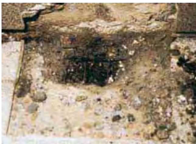
Zawilgocony jastrych z powodu braku uszczelnienia – problem higieniczny np. w kuchniach.
