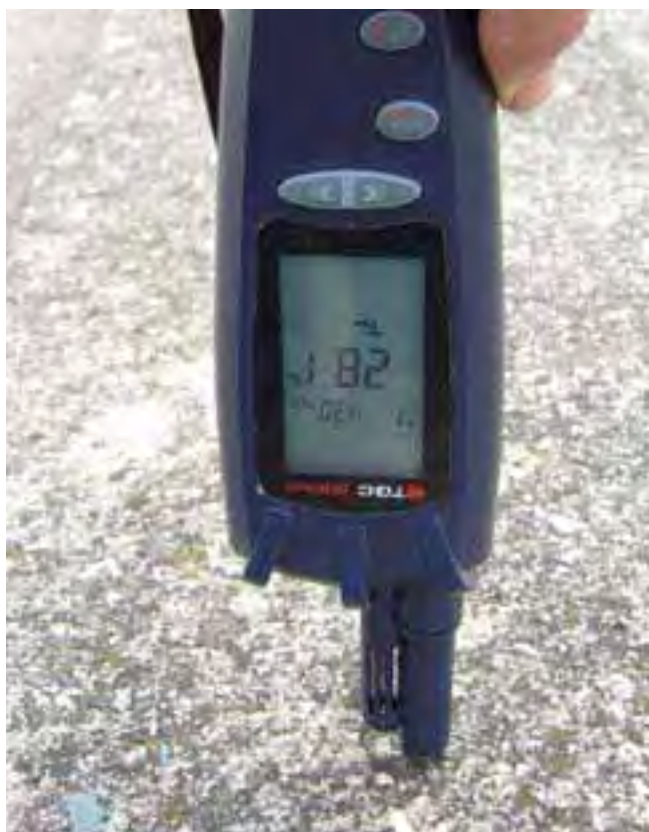
Pomiar temperatury elementu konstrukcyjnego.
