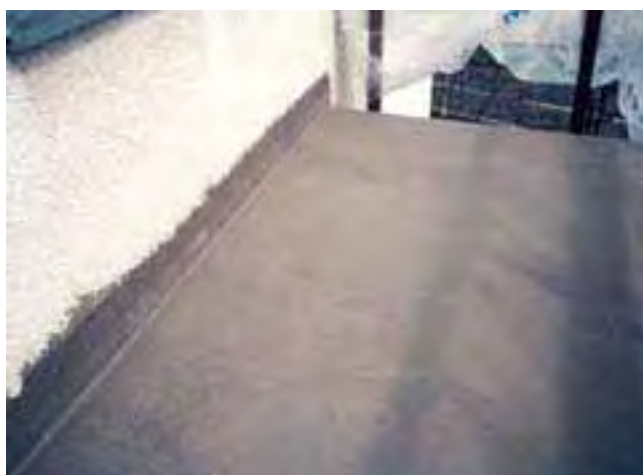
4 Powierzchnia balkonu uszczelniona dwuwarstwowo, zaprawą uszczelniającą Sopro DSF 523, o łącznej grubości warstwy 2 mm.
