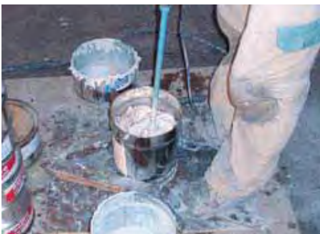
3 Dokładne mieszanie składników A i B elastycznej powłoki uszczelniającej Sopro PU-FD.
