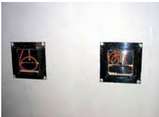
Armatura pod tynkiem z ramką uszczelniającą ...
