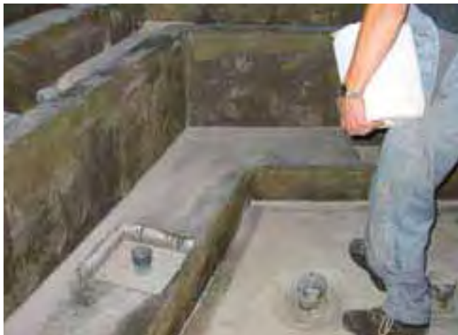
1 Nanoszenie preparatu epoksydowego Sopro EPG z posypką z piasku kwarcowego.
