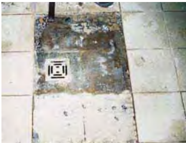
Brak uszczelnienia w okolicy wpustu podłogowego.
