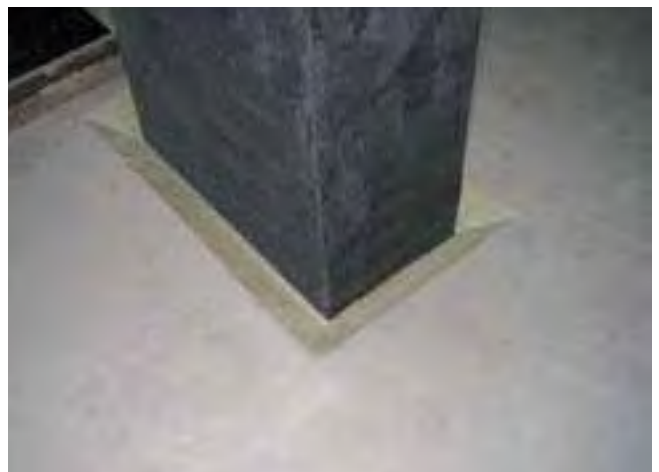
Wycięty fragment jastrychu do wbudowania uszczelnienia.
