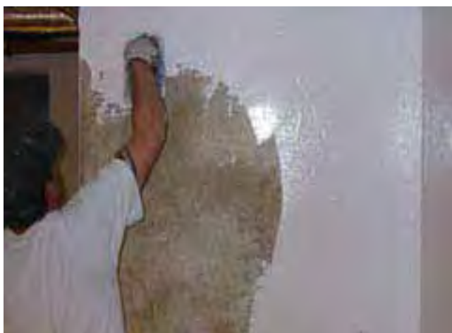
4 Nanoszenie elastycznej powłoki uszczelniającej Sopro PU-FD na ścianę w dwóch warstwach o łącznej grubości 1 mm.
