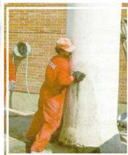
Wypełnienie ubytku zaprawą, dociśnięcie zaprawy do czasu jej związania (ok. 2 min.)
