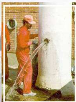
Stopniowe uzupełnianie ubytku zaprawą
