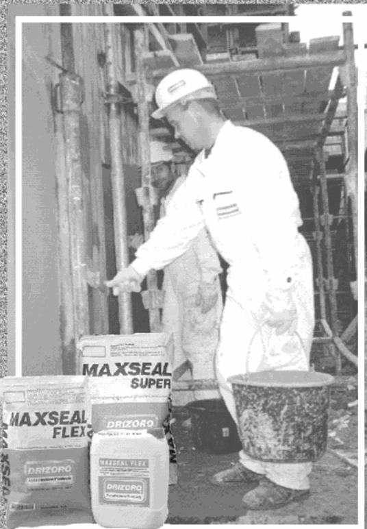
Aplikacja szczotką izolacji mineralnej.
